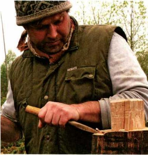
Abb. 5: An den oberen Enden der Wandpfosten haben wir rechteckige Zapfen angebracht, die mit Stemmeißeln aus Bronze gefertigt wurden.
