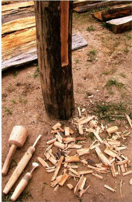
*Abb. 10: Im östlichen Gebäudeteil wurden die Wandpfosten mit Schlitzlöchern versehen, um die Spaltbohlen einschieben zu können; als Stemmbeitel geschäftete Randleistenbeilklingen waren für diesen Arbeitsschritt sehr gut geeignet.*
