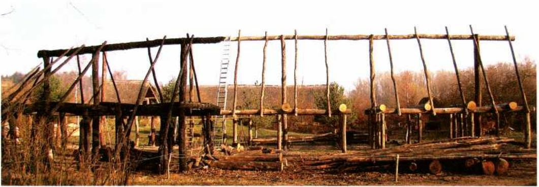
Abb. 7: Wand- und Firstpfetten dienen als Auflager für die Rofenbäume der Dachkonstruktion; vorne links ist noch ein Teil des abgebrannten Hauses zu sehen.
