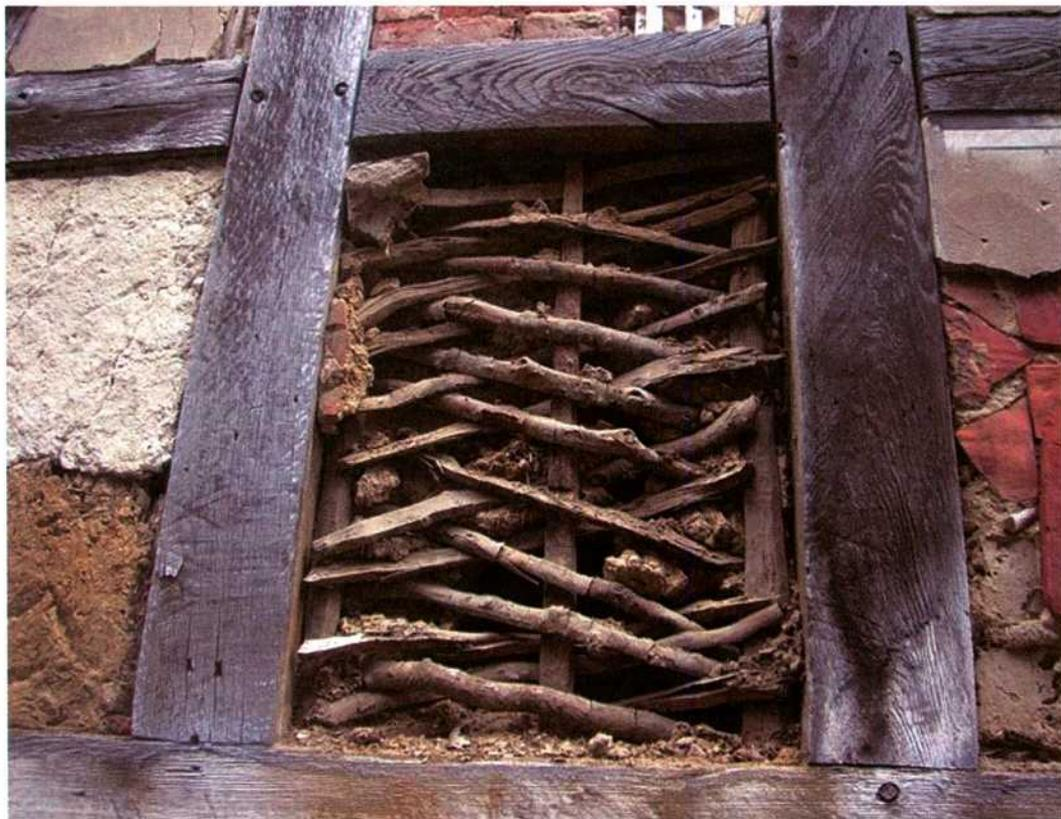
Abb. 2: Neuzzeitliche Ausfachung einer Fachwerkwand in Rauschholzhausen.
