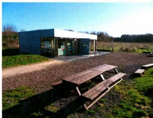
Abb. 5: Seit dem Frühjahr 2008 werden die Gäste des Steinzeitparks Albersdorf im neuen Servicegebäude begrüßt und auf ihre „Reise in die Steinzeit“ eingestimmt.
