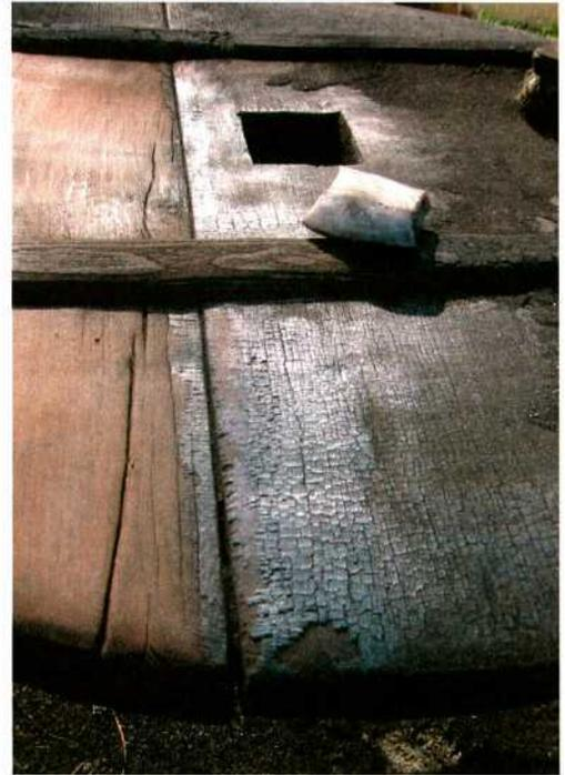
*Abb. 10: Unter der dünnen Holzkohleschicht befindet sich die harte, fast metallisch glänzende Oberfläche des geschmauchten Rades.*
