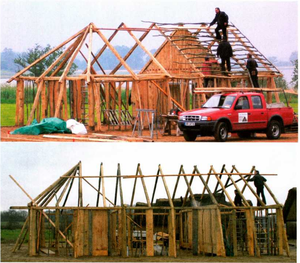
Abb. 9: Zweifache Rekonstruktion desselben Baubefundes. oben: Gerüst Haus 1. unten: Gerüst Haus 7.
