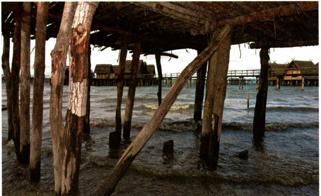
Abb. 10: Zur Absicherung der Baukonstruktion werden Schrägpfähle unterstellt, Mai 2000.
