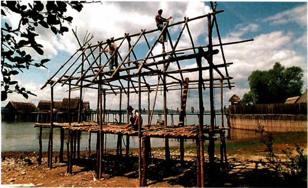
Abb. 3: Aufbau des Hornstaadhauses im Freilichtmuseum Unteruhldingen 22. Mai 1996. Das Rohgerüst ist fertig.
