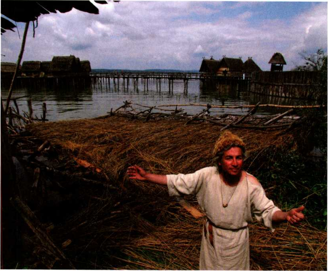
Abb. 11: Orkanschaden – das Haus am 30. Mai 2009.
