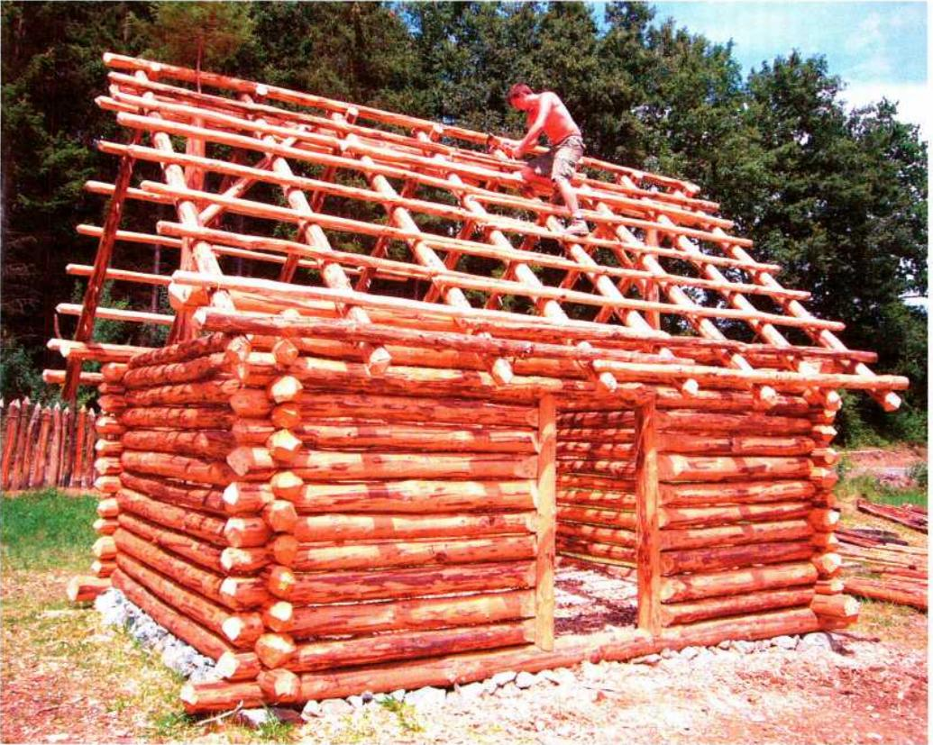
*Abb. 14: Die Holzkonstruktion des Blockbaus mit Streben, Rofenbäumen und Lattenhölzern; die obersten Längsbalken der Blockbauwände kragen an den Stirnseiten etwas vor und dienen als Fußpfetten; alle Holzverbindungen wurden mit Holznägeln gesichert. – The timber building of the log construction with braces, rafters and laths; the uppermost pair of longitudinal beams is jettied on the ridge sides and serves as wall plates; all joints are safeguarded with wooden pegs.*
