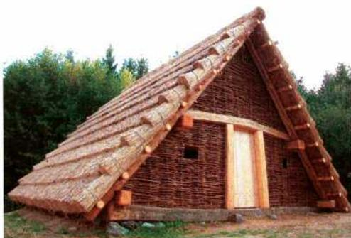
Abb. 7: Unser Grubenhausmodell mit Schilfdach, Wendeböhlertür und Flechtwänden vor dem Verputzen derselben; im Inneren wurde eine Holzwerkstätte eingerichtet. – Our pit house model with reed roof, ledged door leaf and wattle walls before plastering; in this house a wood workshop was installed.
