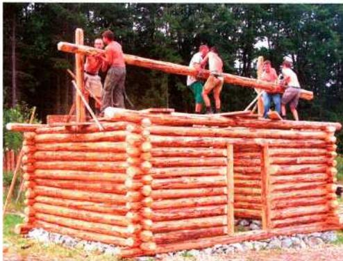
Abb. 13: Die Firstpfette des Blockhauses wurde mit Zapfenverbindungen auf Firstsäulen aufgesetzt, die später durch zwei Streben in Längsrichtung gesichert wurden; vorne führt ein Türbereich zum zentralen Platz. – The apex purlin of the log cabin house was put on rigde posts with shouldered tenons and safeguarded with two upward braces; on the front side a door is leading to the central place of the settlement.
