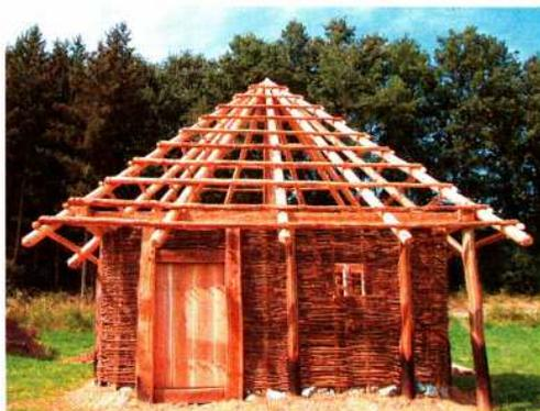
Abb. 10: Die Holzkonstruktion unseres Wohnhauses in Pfostenbautechnik mit Türbereich und Flechtwerkwänden; das archäologische Vorbild für dieses Hausmodell stammt aus Baumgarten an der March in Niederösterreich. – The wooden construction of our living house in post building technique with door area and wattle walls; the archaeological evidence for this house model stems from Baumgarten in Lower Austria.
