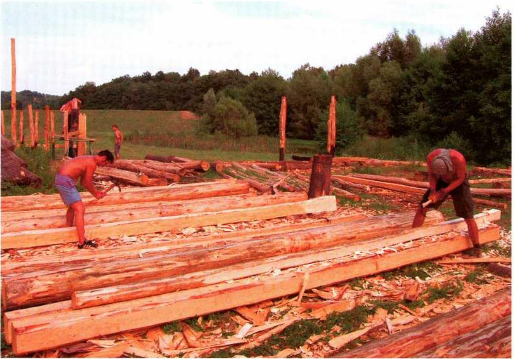
*Abb. 4: Bei experimentellen Versuchen zur flächigen Bearbeitung von Bauhölzern wurden neben Äxten und Bartäxten auch Dechseln eingesetzt. – Our experiments concerning the flattening of rectangular building woods were done with axes and adzes.*
