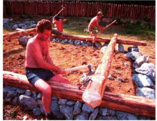
Abb. 12: Die halbrunden Ausnehmungen an den Schwellen des Blockhauses werden mit Äxten unterschiedlicher Form ausgenommen, um den ersten Kranz zusammen zu fügen; Bartäxte erwiesen sich dabei als besonders effektiv. – The half round notches of the threshold beams of the log cabin house were formed with axes of different shapes to join together the first layer of logs; bearded axes turned out to be very effective for this purpose.
