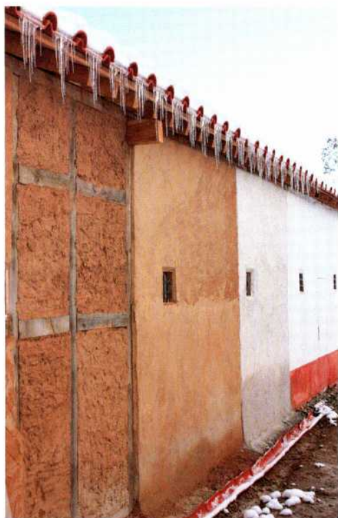
Abb. 10: Die Westseite der Fabrica dient als Versuchsfläche. Hier wird ermittelt, wie dauerhaft verschiedene Oberflächen sind. – The western front of the fabrica is a test zone, that will show how stable different surfaces are.
