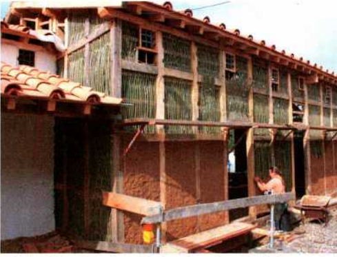
Abb. 13: An der Ostseite der Fabrica sind verschiedene Baustadien zu erkennen. – The east front of the fabrica shows different states of construction.
