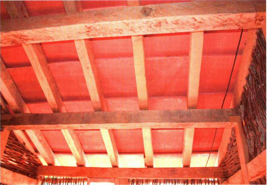
Abb. 6: Blick von unten auf das Dach. Die Tegulae sind 45 x 55 cm groß und liegen direkt auf den Sparren, ohne Dachlatten. – View from below to the roof. The tegulae measure 45 x 55 cm and lie upon the rafters, without roof laths.
