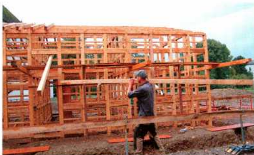
Abb. 11: Fast alle Balken waren leicht genug für eine Person. – Almost all beams could be handled by one person.
