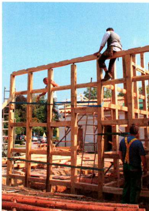
Abb. 5: Die Wandpfosten stehen in regelmäßigen Abständen von etwa 90 cm und reichen vom Boden bis unter die Fußpfette. – The distance between the posts is about 90 cm. They reach from the ground to the roof beam.
