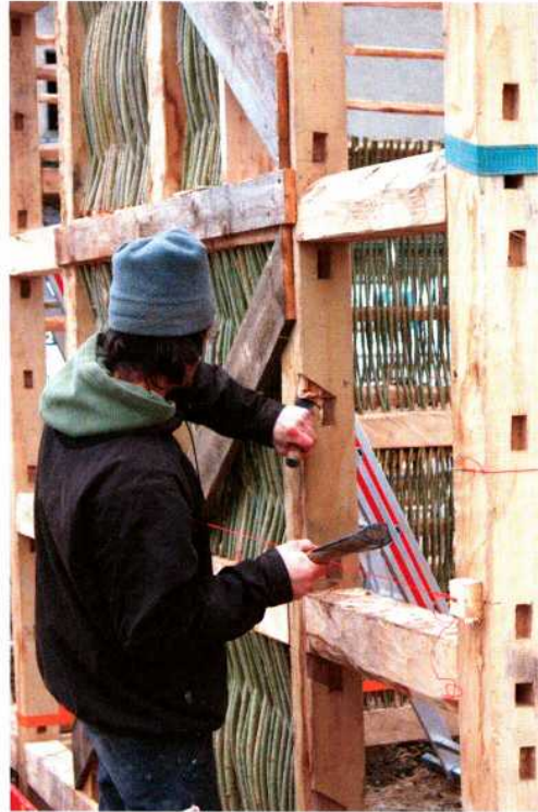
Abb. 7: Alle Holzverbindungen entsprechen genau den römischen Vorbildern. – All timber joints are conform to the roman originals.
