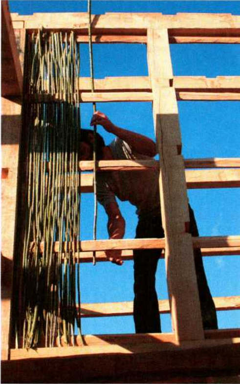
Abb. 8: Die Weidenruten werden senkrecht eingeflochten. – The osier stakes are wattled vertically.
